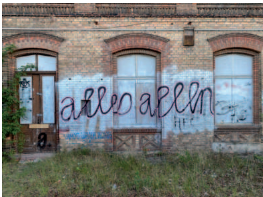
Bahnhof Könnern „alles allein“, Foto: Werkleitz 2022
